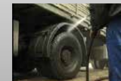
Мойка колес на стройке
