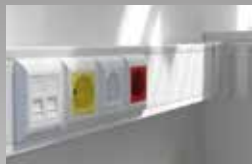
Установка слаботочных сетей (телефония и Интернет)
