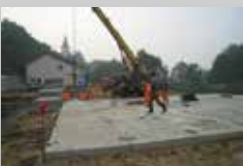
Подготовка основания под установку модульного здания
